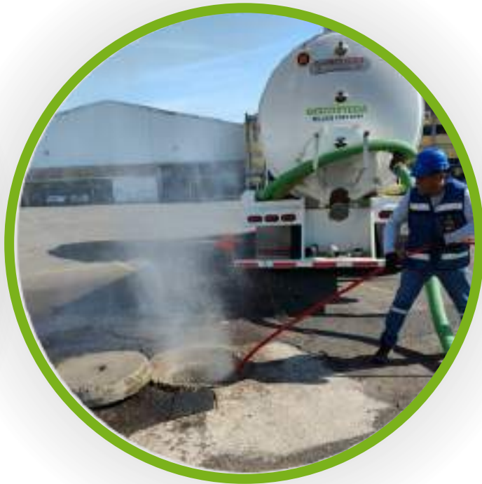
Sondeo y limpieza de drenajes
