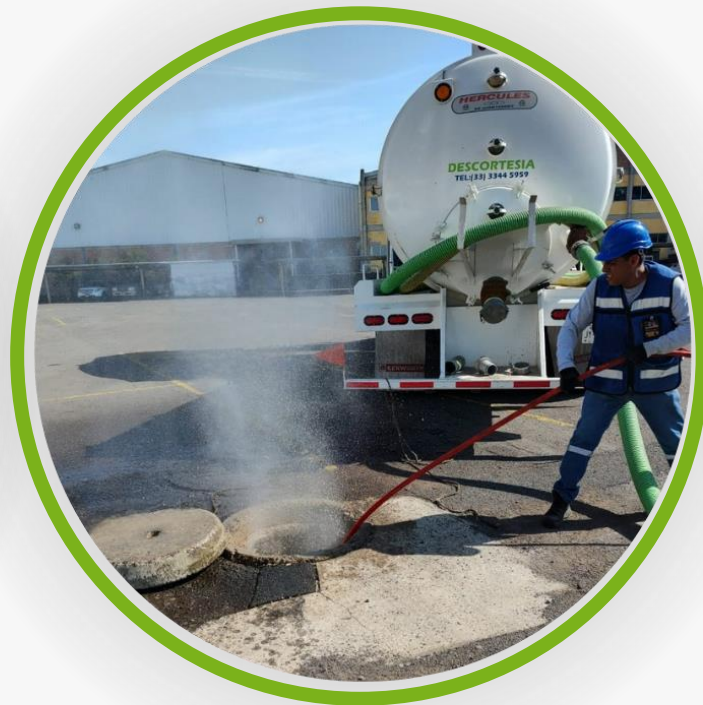
Sondeo y limpieza de drenajes
