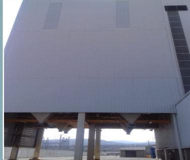
Mantenimiento y Reparaciones.
