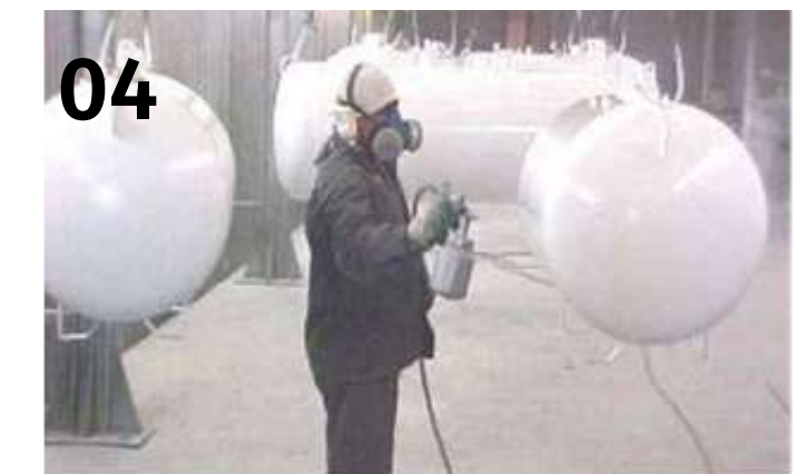
Aplicación de pintura (opcional)
