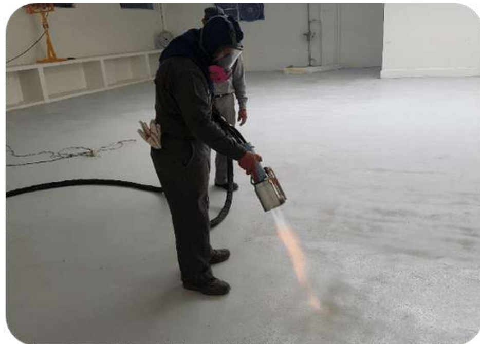
Plastificado sobre piso de concreto
