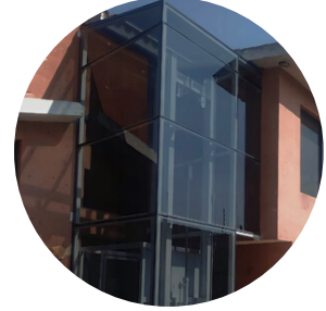
OBRA PERIMETRAL Y ESTRUCTURAL
