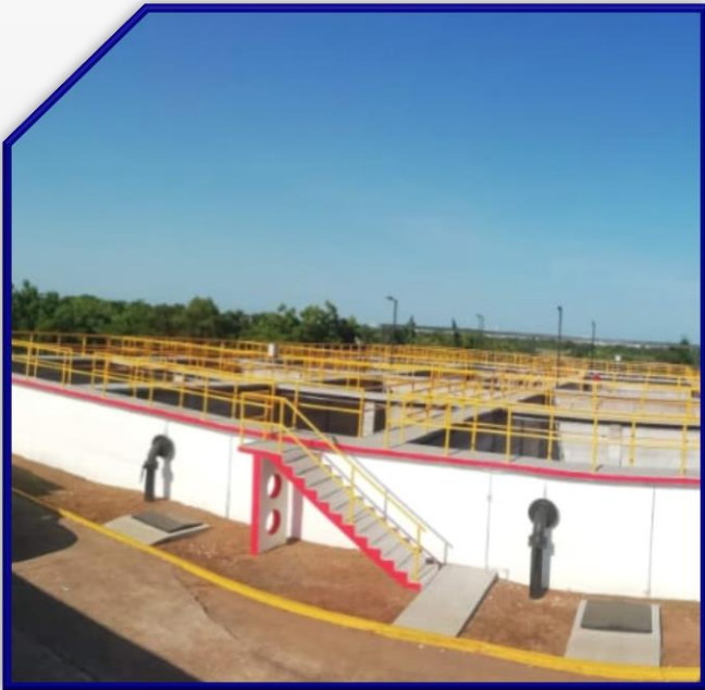
Plantas de tratamiento de aguas residuales
