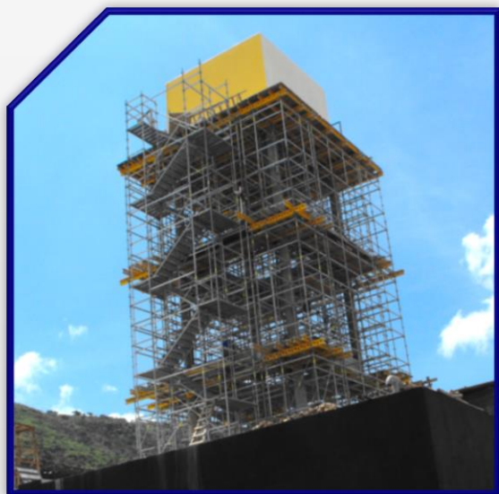
Construcción de infraestructura
