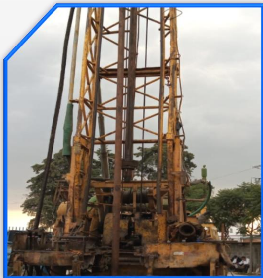
Perforación y Rehabilitación de pozos
