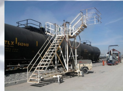
ESCALERA DE TRASVASE
