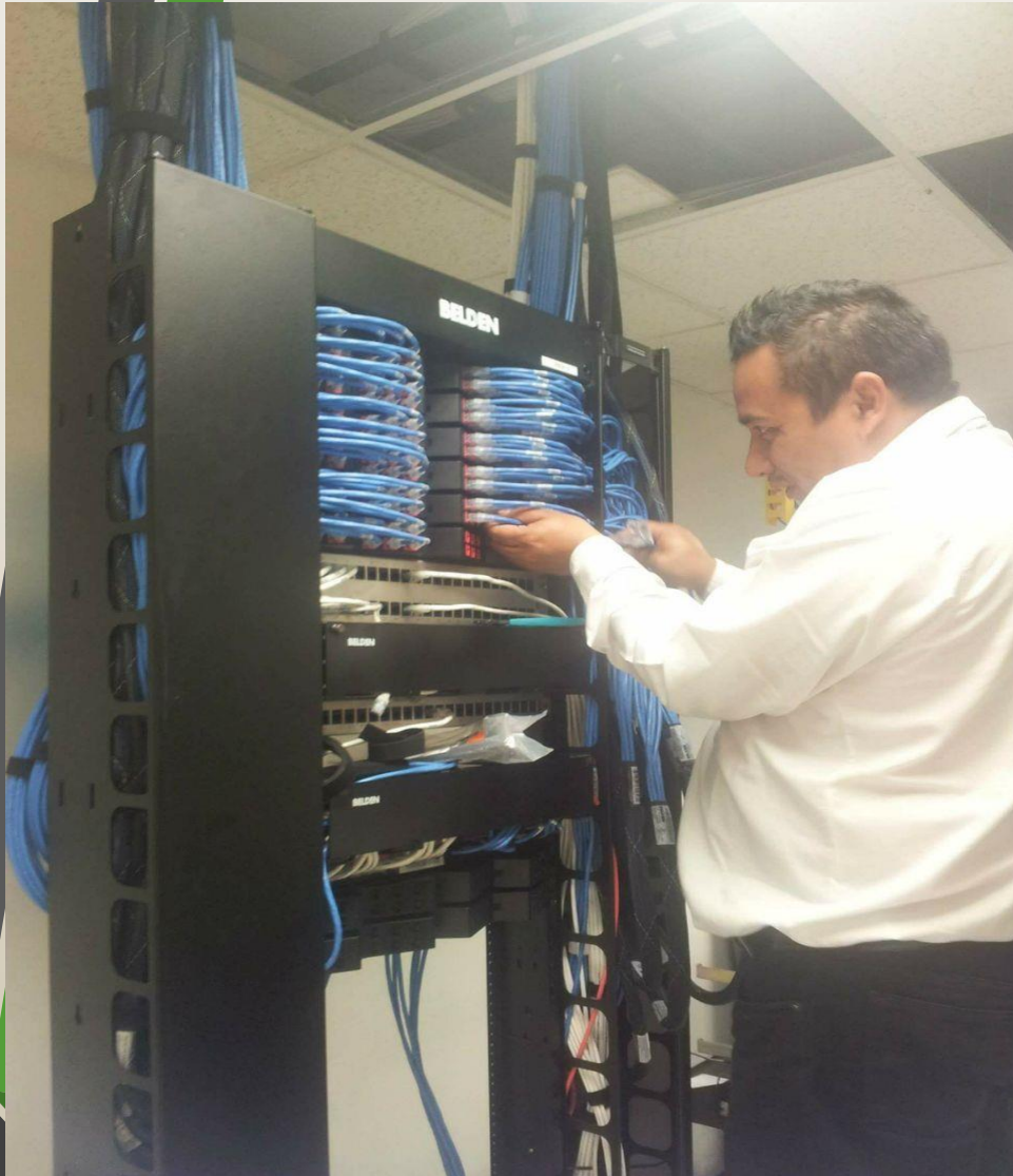
UTP- F. O. Terminación en panel.
