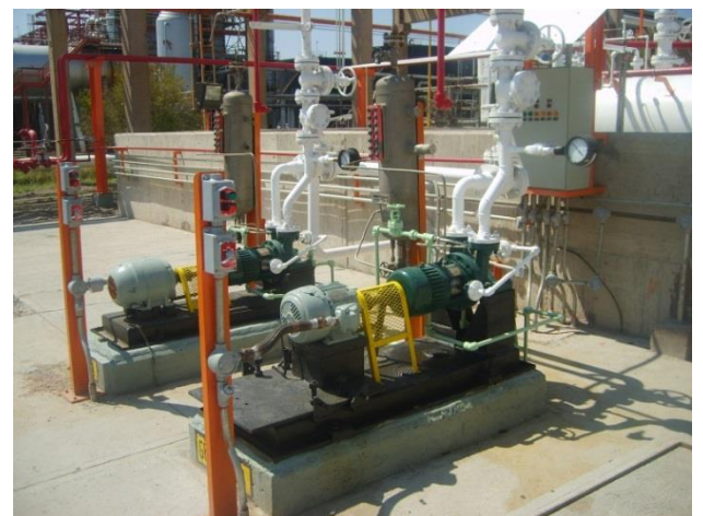
REHABILITACION DE BOMBAS CENTRIFUGAS. (después)
