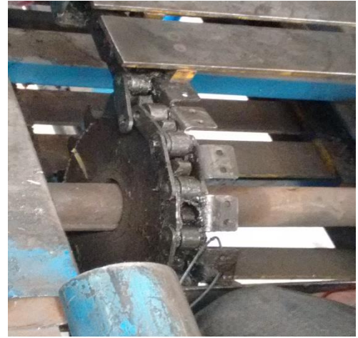
REPARACION DE MECANISMOS
