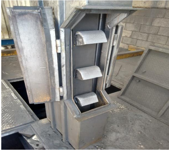
INSTALACION DE BANDA DE CANJILONES
