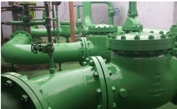
RESTAURACION Y PINTURA TUBERIA
