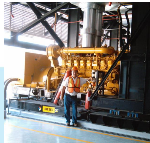
TANQUES BAJO MOTOR DE MOTO GENERACIÓN
