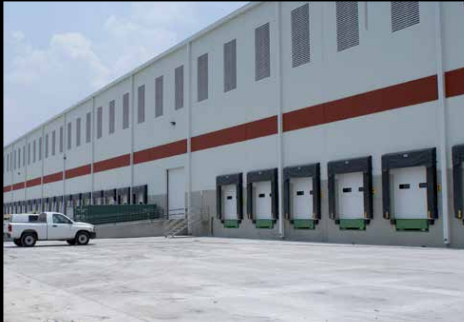
Centro de Distribución Oxxo, Querétaro
