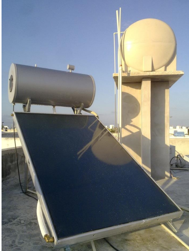
MÉRIDA, NOVIEMBRE 2014, CAENSOL ORO 200 LITROS CON RESISTENCIA INTEGRADA
