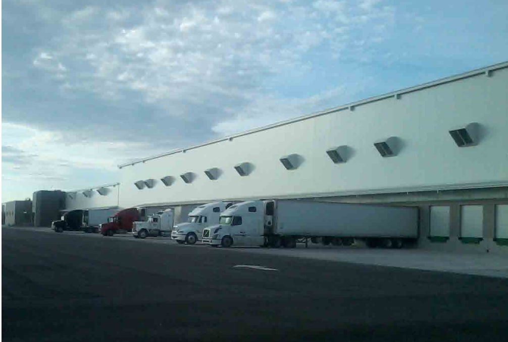
CENTRO DE DISTRIBUCIÓN ALSUPER GÓMEZ PALACIO, DURANGO 30,000 M2 OBRA CIVIL, CIMENTACIONES, MUROS CONTENCIÓN, MUROS BLOCK, PISOS DE CONCRETO, BARRA PERIMETRAL, BANQUETAS. AÑO 2015
