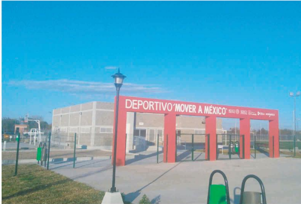
CENTRO DEPORTIVO MOVER A MÉXICO FRANCISCO I MADERO, COAHUILA 500 M2 CONSTRUCCION, 1 HA CANCHAS, LLAVE EN MANO AÑO 2016
