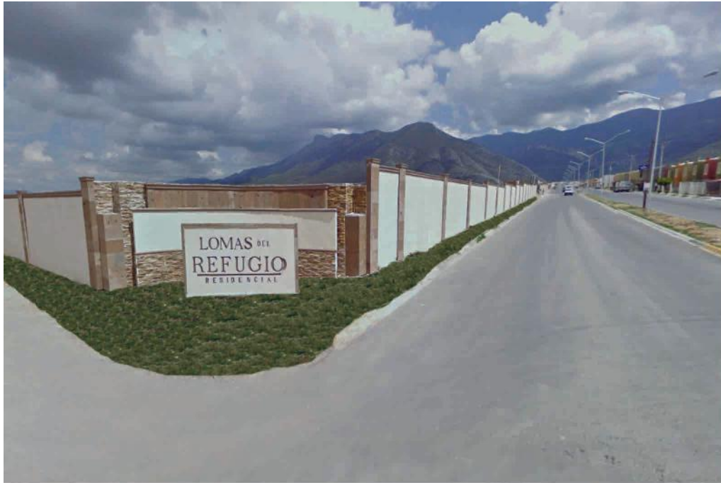
FRACCIONAMIENTO "NUEVO LOMAS DEL REFUGIO" DAVISA SALTILLO, COAHUILA 800 LOTES URBANIZACIÓN AÑO 2015
