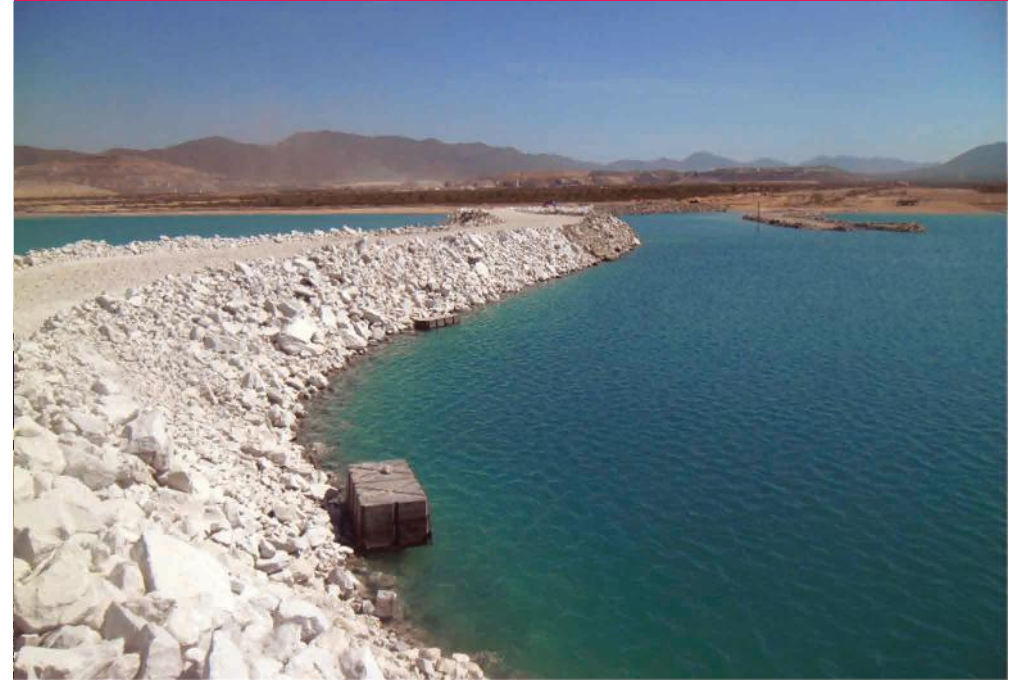
PEDRAPLÉN EN PRESA DE JALES MINERA PEÑASQUITO, GOLD CORP MAZAPIL, ZACATECAS MOVIMIENTO DE 1 MILLÓN M3 PIEDRA AÑO 2014
