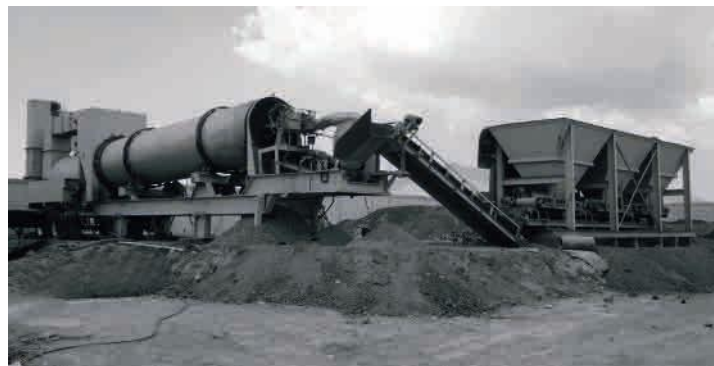
PLANTA DE ASFALTO
