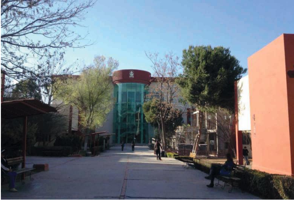
EDIFICIO AUDITORIO Y BIBLIOTECA UANE SALTILLO, COAHUILA 2,800 M2 ACABADOS AÑO 2008
