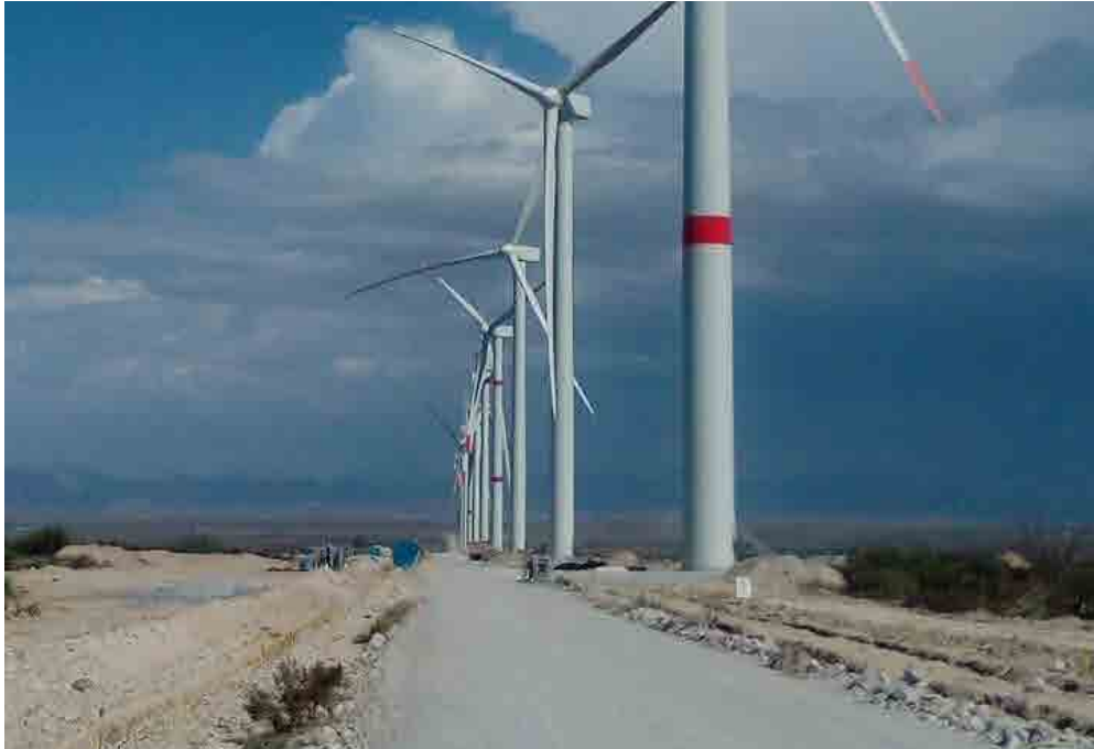
PARQUE EOLICO DE COAHUILA 200 MW GLOBAL ENERGY SERVICES HIPÓLITO, COAHUILA 20 KM CAMINO Y VIALES (TERRACERÍA Y BASE), 40,000 M3 EXCAVACIÓN AÑO 2016
