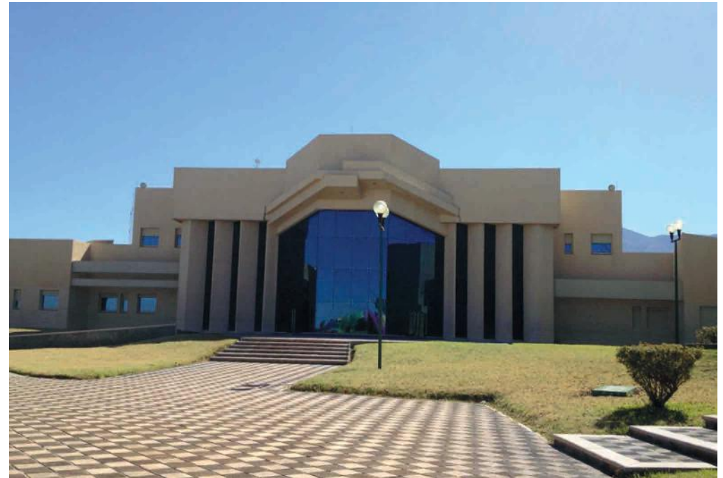
EDIFICIO DE SEGURIDAD PÚBLICA DEL ESTADO SALTILLO, COAHUILA 6,500 M2 ESTRUCTURA METÁLICA Y ELECTRIFICACIÓN AÑO 2005
