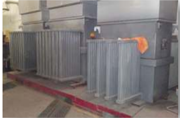
Mantenimiento a Subestación Eléctrica del Palacio de Gobierno de Monterrey, N.L. Marzo de 2014
