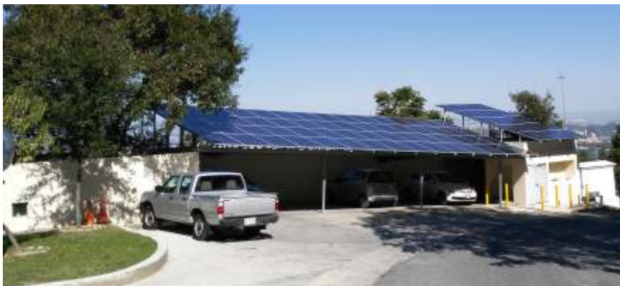
Instalación de Paneles Solares, Residencia en Pedregal del Valle, San Pedro Garza García, Nuevo León, México.
