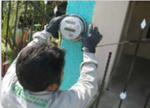
Instalación de Medidores en Área Metropolitana de Monterrey, N.L. Todo el año 2014
