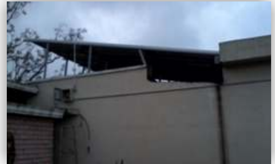
Residencia en Monterrey, Nuevo León, México, Febrero de 2015
