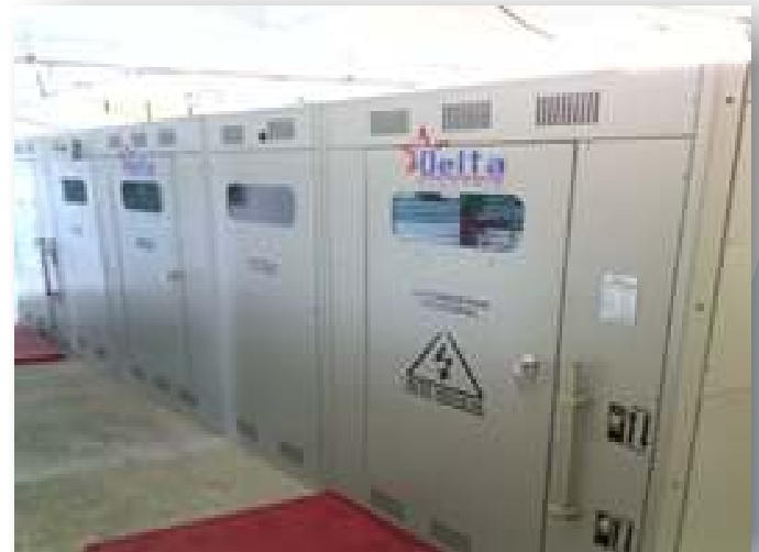
Fabricación de Subestación, Tablero de Distribución y CCM para motores de 300hp en estación de Bombeo Los Reyes de la Paz Edo. de México Proyecto CARCAMO (GIA), Abril 2014
