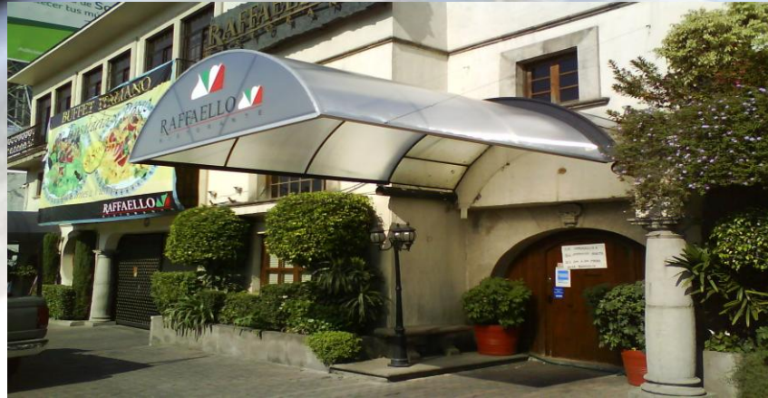
Cubierta de policarbonato.-
