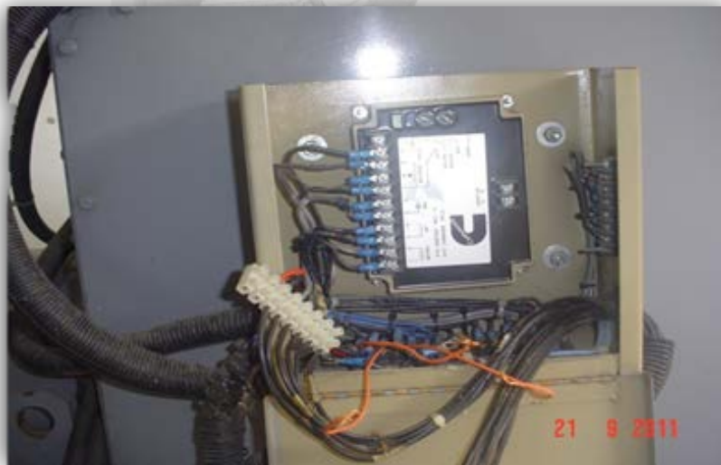
Suministro de control de gobernador para motor Cummins
