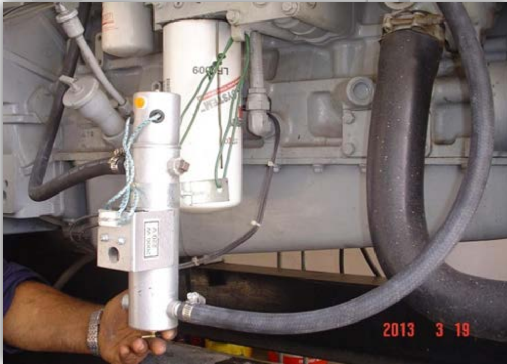
Suministro de precalentador para motor diesel de 2000 watts a 220 vca.
