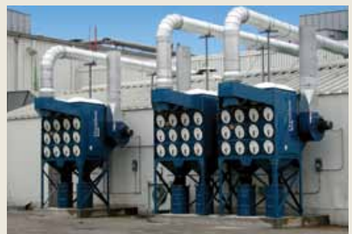
DFO Flama de polvo metalizado 20,500 cfm
