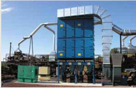
DLMC Aplastamiento de Roca 41,000 cfm
