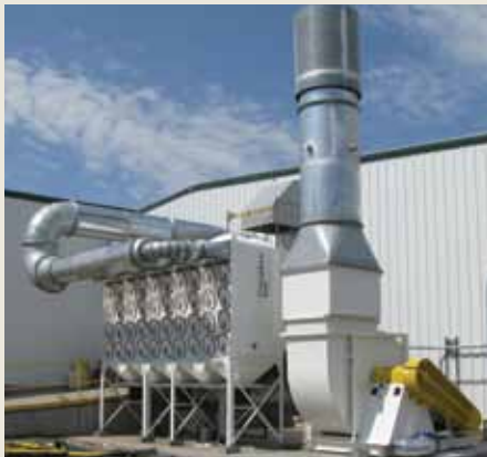
DFO Cascarillado y clasificación de maíz 28,500 cfm
