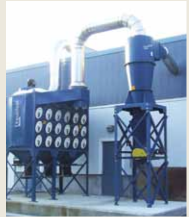
DFO Espray Térmico 4,800 cfm
