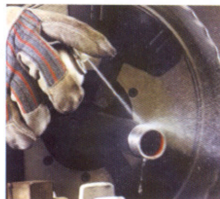
Después de roscar, use un rociador desengrasante para limpiar las roscas y el interior del tubo conduit.
