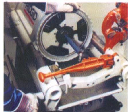
Use un torno para quitar cualquier borde filoso. Esto asegurará que no se dañe el cable jalado a través del tubo conduit
