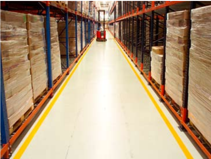
Mortero epóxico a 3 y 6 mm en áreas de producción y pasillos.
