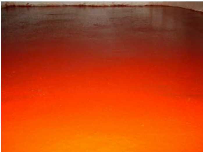
Sistema Mortero Cementicio Uretano a 7 mm de espesor en cámaras de congelación.
