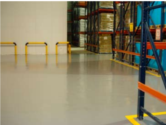
Sistema Mortero epóxico a 4mm, en áreas de producción de almacén y pasillos.
